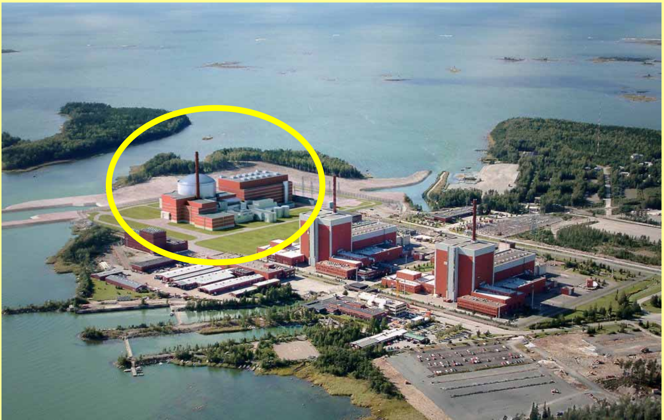
L'immagine costituisce una elaborazione grafica dell'impianto in costruzione.
