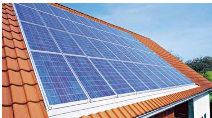
Sono esonerati dal Registro gli impianti realizzati in sostituzione di tetti in amianto
