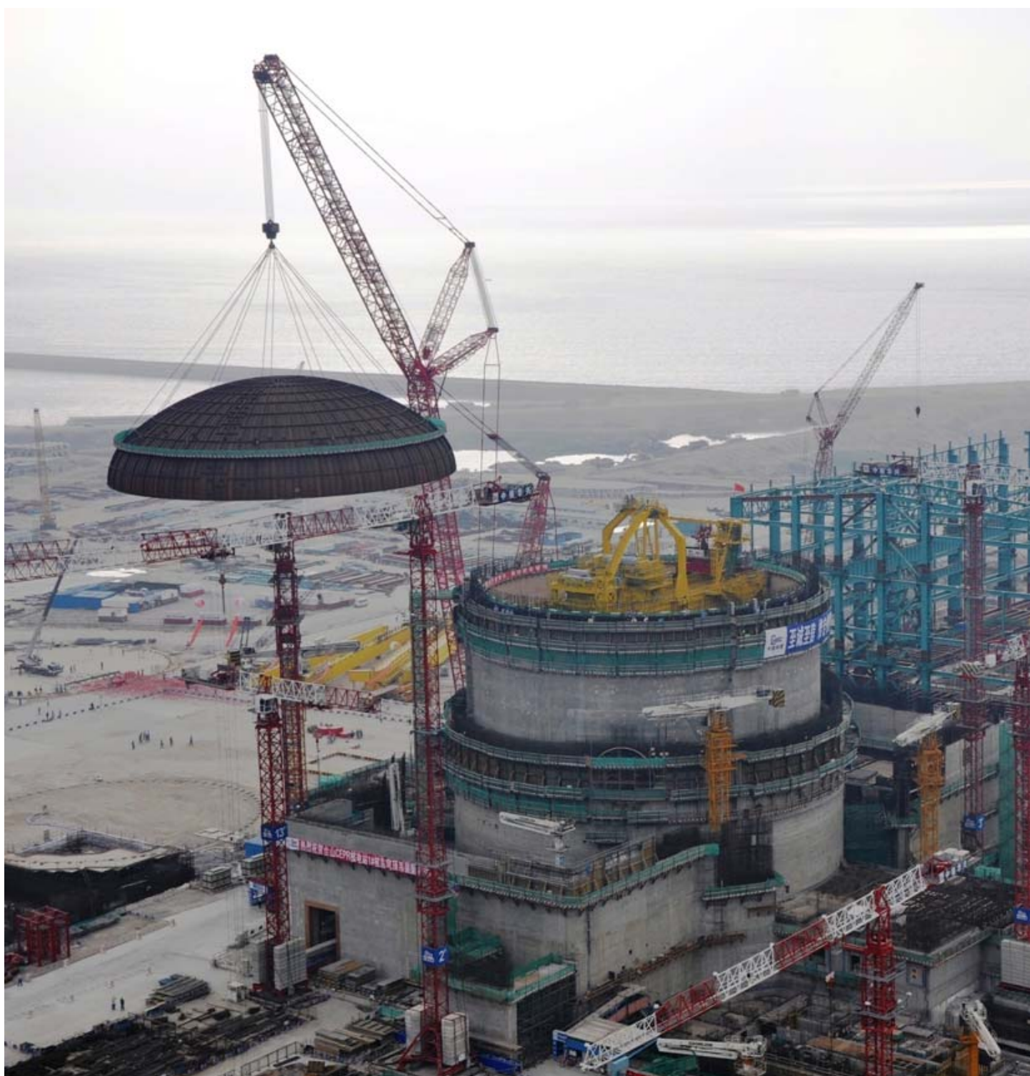
La centrale cinese di Taichan in costruzione.
