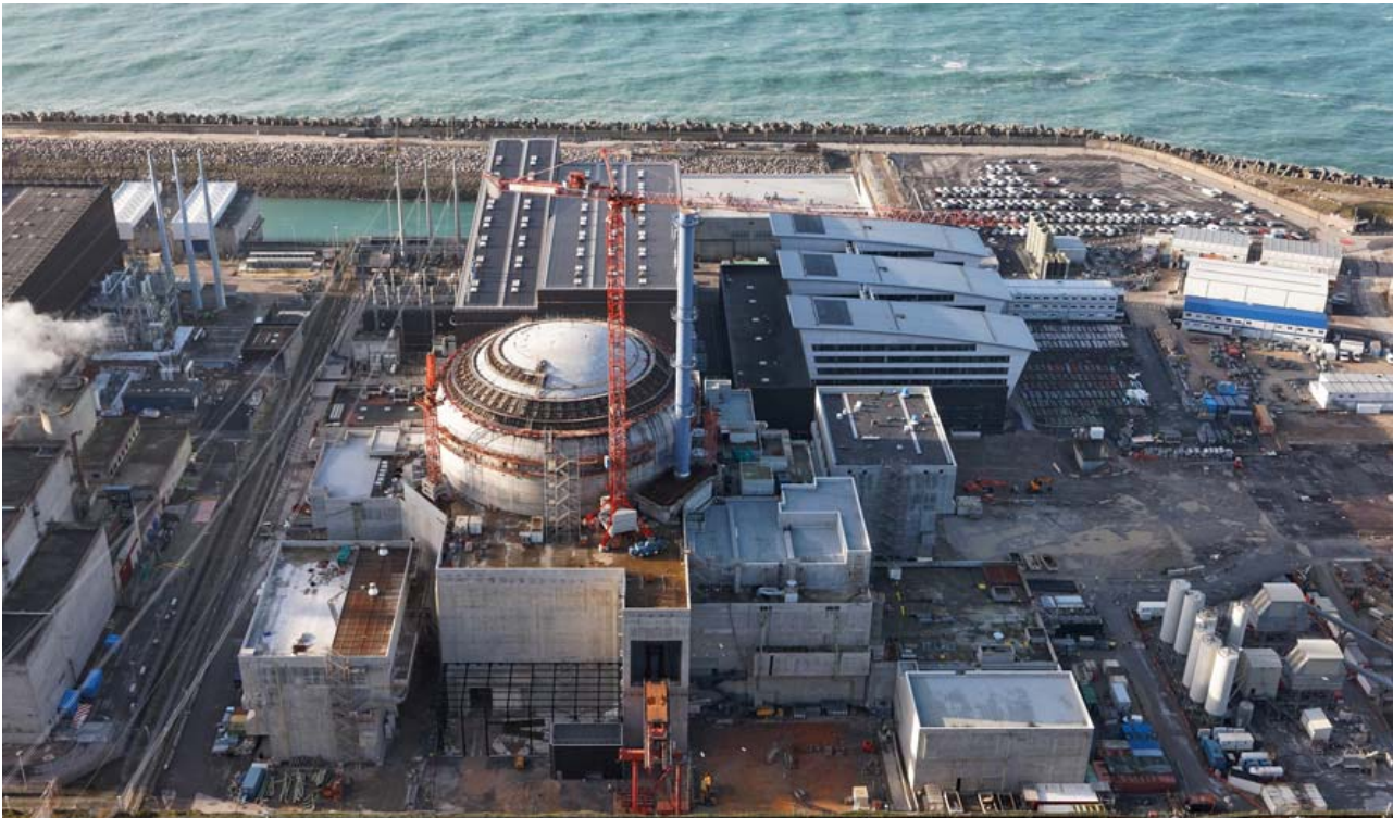
Il cantiere di Flamanville (foto EDF)
